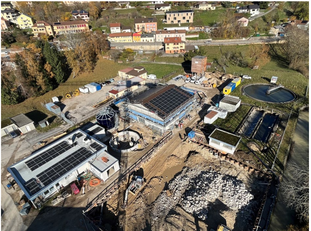
Travaux à la STEP
