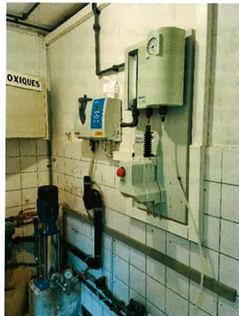
Station de dosage et système d'alarme en cas de fuite
