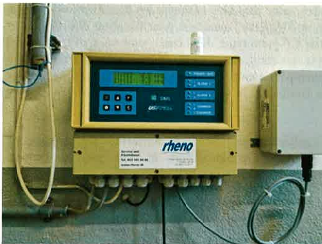
Station de dosage et système d'alarme en cas de fuite
