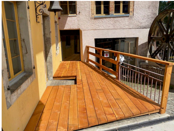
Création et installation d'une terrasse
