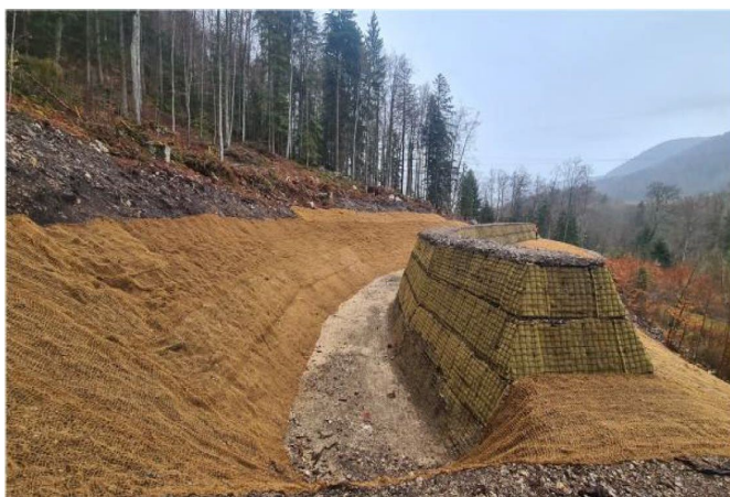
Digue de protection, La Source
