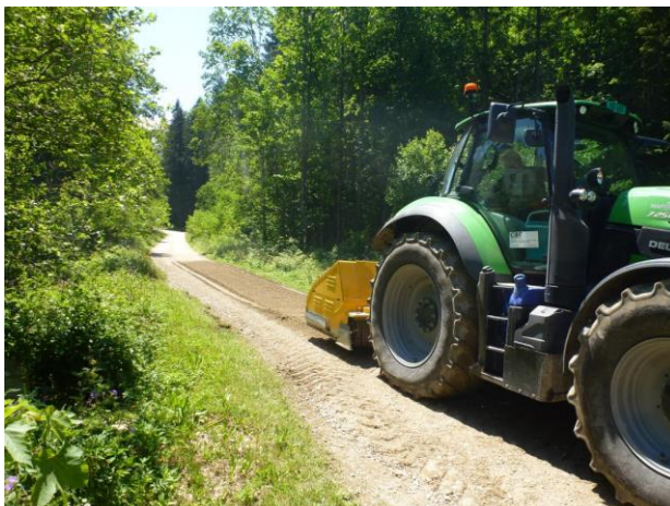
Réfection du chemin de l'ancienne route de la Vallée
